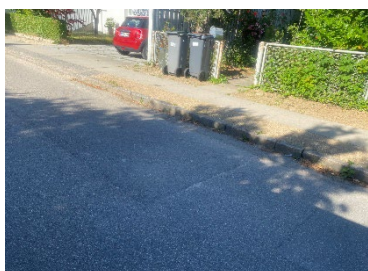
Retablering af en opgravning
