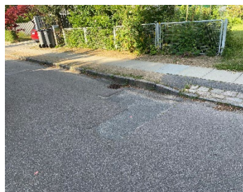
Retablering af en opgravning
