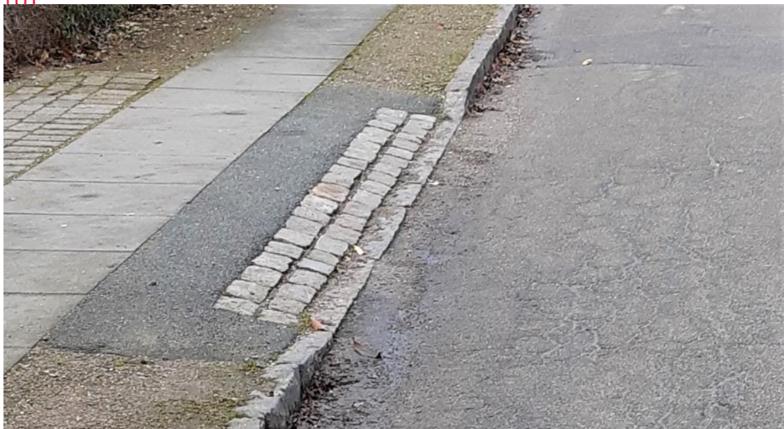
Foto 4.1.1.1: Standard indkørsel med brostens-rampe
