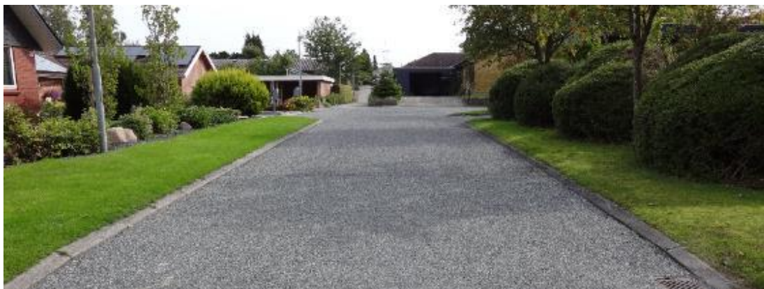
Foto 4.1.3.1: Eksempel på overfladebehandling med 5/8 mm skærver, udlagt på boligvej
