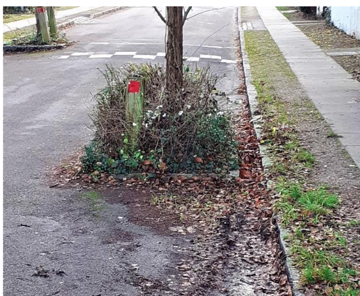
Foto 3.2.4.1: Partier langs kantsten med ringe afvanding, pga. manglende fald mod afløb, og renholdelse.
