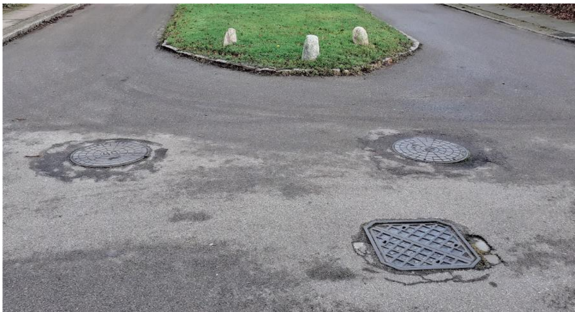
Foto 3.2.5.1 Brønde ved Langvaddam. Den faste (firkantede) brønd er sat med brosten, som det ses!
