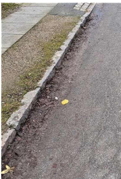
Foto 3.2.4.1: Partier langs kantsten med ringe afvanding, pga. manglende fald mod afløb, og renholdelse.
