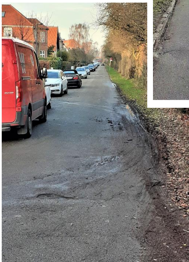
Foto 3.5.2: Ålstrupvej set mod nord, fra sydenden. Afvandingen er for dårlig. Vejen er for smal til svingende trafik.
