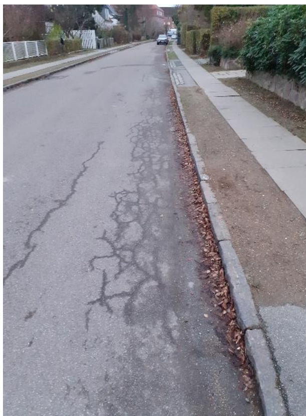
Foto 3.4.3: Parti med mange revner, vej- side mod vest. Bør udskiftes.
